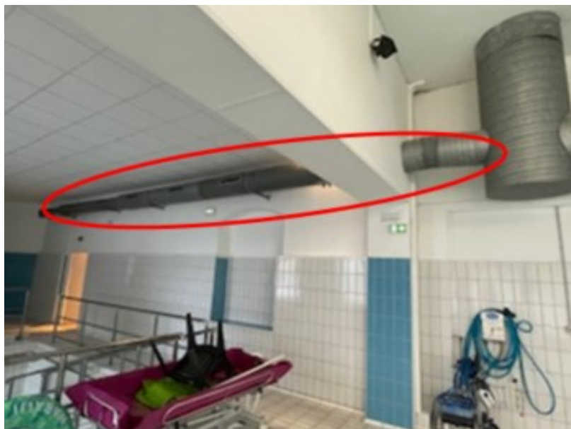
Réseau Extraction à modifier, réduire et mettre dans faux plafond
